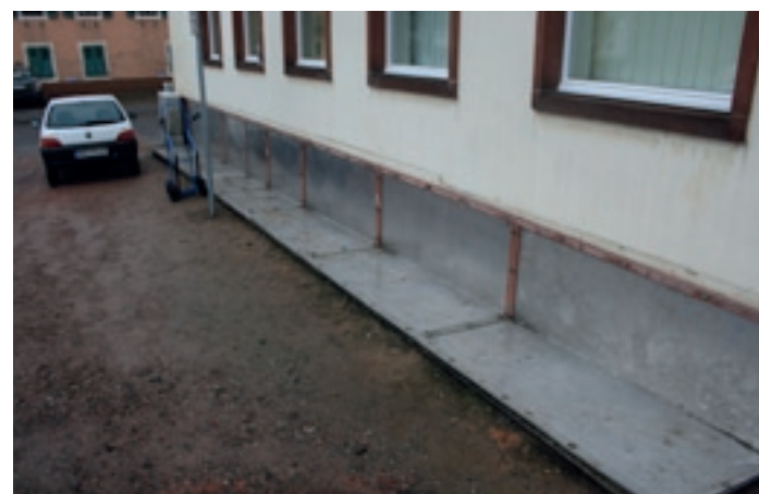
Abb. 8: Verschlussystem für Kelleröffnungen (IKSMS)
