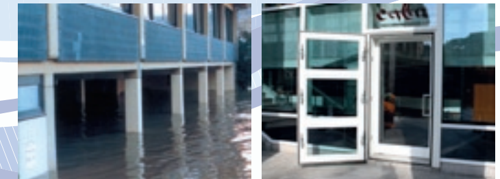
Abb. 6: Beispiele Bauvorsorge: a) aufgeständertes Baukörper (IKSMS) und b) Druckwasserdichte Verschlusssysteme für Türen und Fenster, Hamburger HafenCity (FWW)
