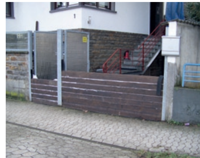
Abb. 9: Private Bauvorsorge – höher gelegter Eingang und Verschluss der Zufahrt mit mobilen Elementen – Koblenz (FWW)
