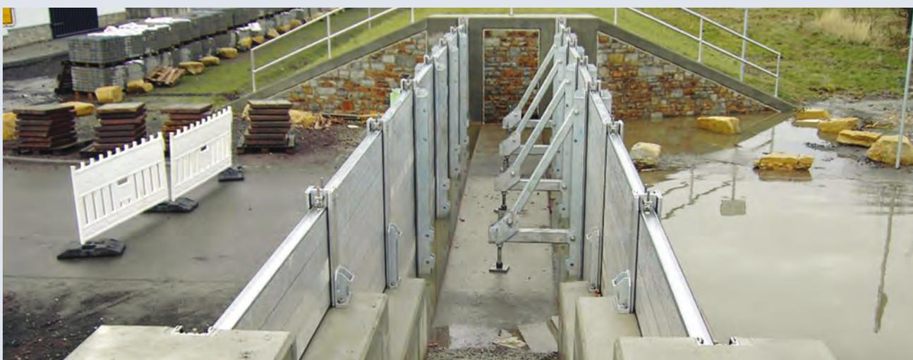
*Mur de protection contre les inondations, surplombé par des éléments mobiles et doté*
